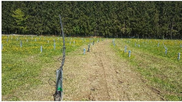
Abbildung 2: Verfüllter Kabelgraben
