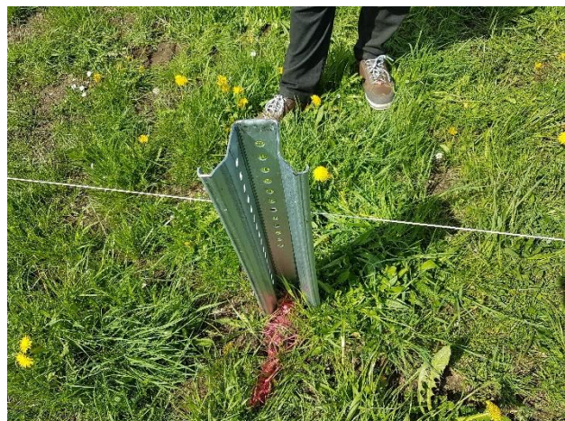
Abbildung 4: Rammfundament
