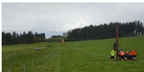
Abbildung 1: Hydraulikramme auf Ketten
